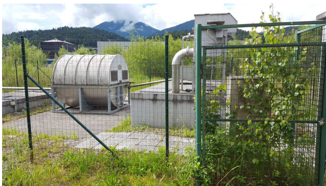
Slika 20: Začasna biološka čistilna naprava 200 PE (Matrika ZVO d.o.o., junij 2016)
