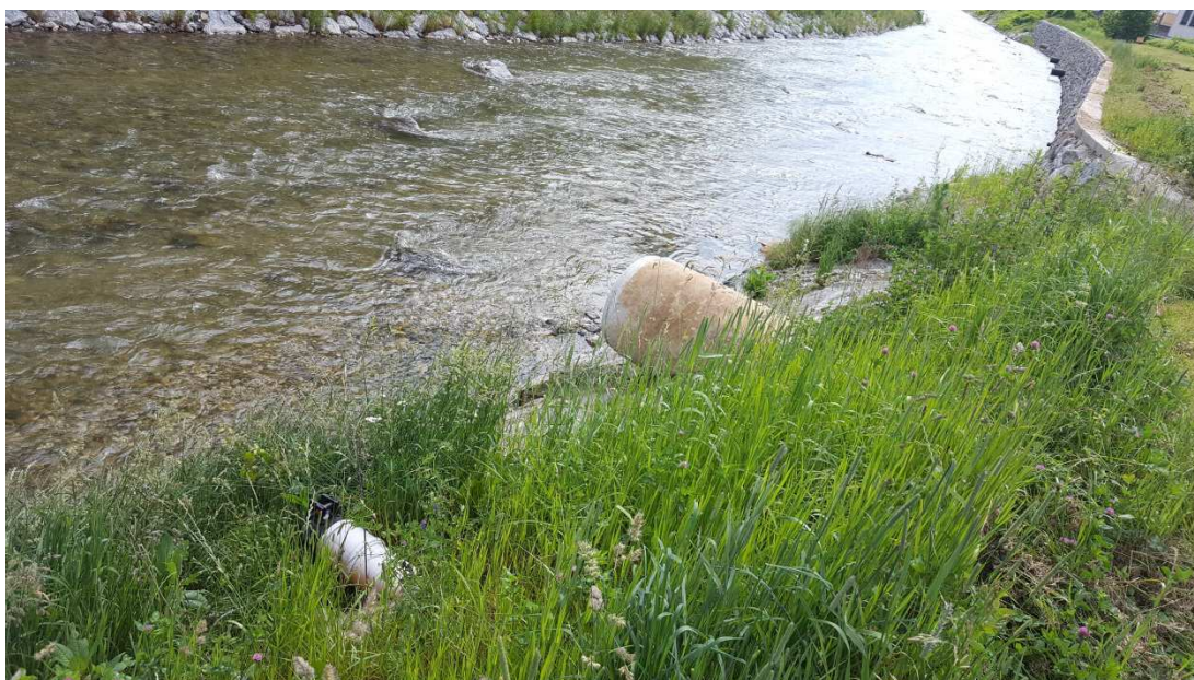
Slika 22: Prikaz iztoka prelivne cevi iz črpališča (leva cev) in iztoka kanalizacije za padavinsko odpadno vodo obstoječe cone GOK (desna cev) (Matrika ZVO d.o.o., junij 2016)
