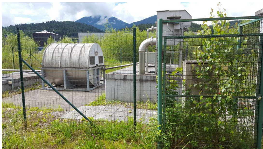
Slika 28: Začasna biološka čistilna naprava 200 PE (Matrika ZVO d.o.o., junij 2016)
